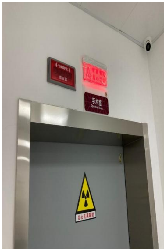
DSA 机房防护门外工作状态指示灯、电离辐射标志、黄色警戒线
